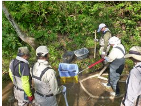
メンテナンス作業風景
