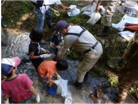
礫の敷きつめ作業風景
